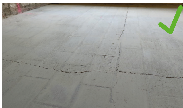
Risse verharzen (bauseits), dann fräsbar
