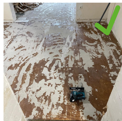
Risse verharzen (bauseits), dann fräsbar
