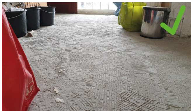
FließBenkleber abschleifen oder nivellieren (bauseits), dann fräsbar
