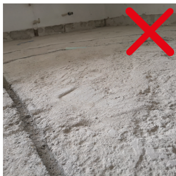
FließBenkleber abschleifen oder nivellieren (bauseits), dann fräsbar
