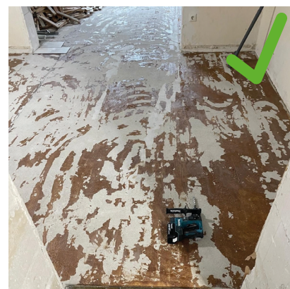
Risse verharzen (bauseits), dann fräsbar
