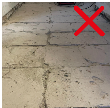
Muss mit standfester Masse repariert werden
