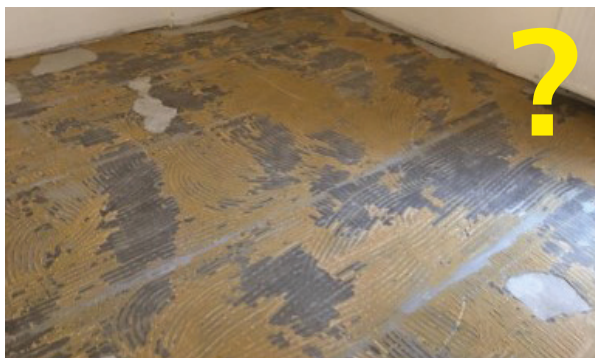
FließBenkleber abschleifen oder nivellieren (bauseits), dann fräsbar
