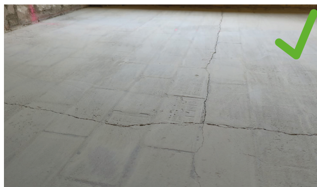
Risse verharzen (bauseits), dann fräsbar
